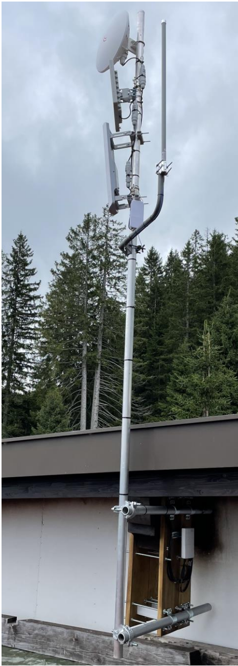
Mastrohr an der Pfette des Treppenhausdaches montiert.
